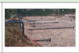
Mise en place des réseaux
